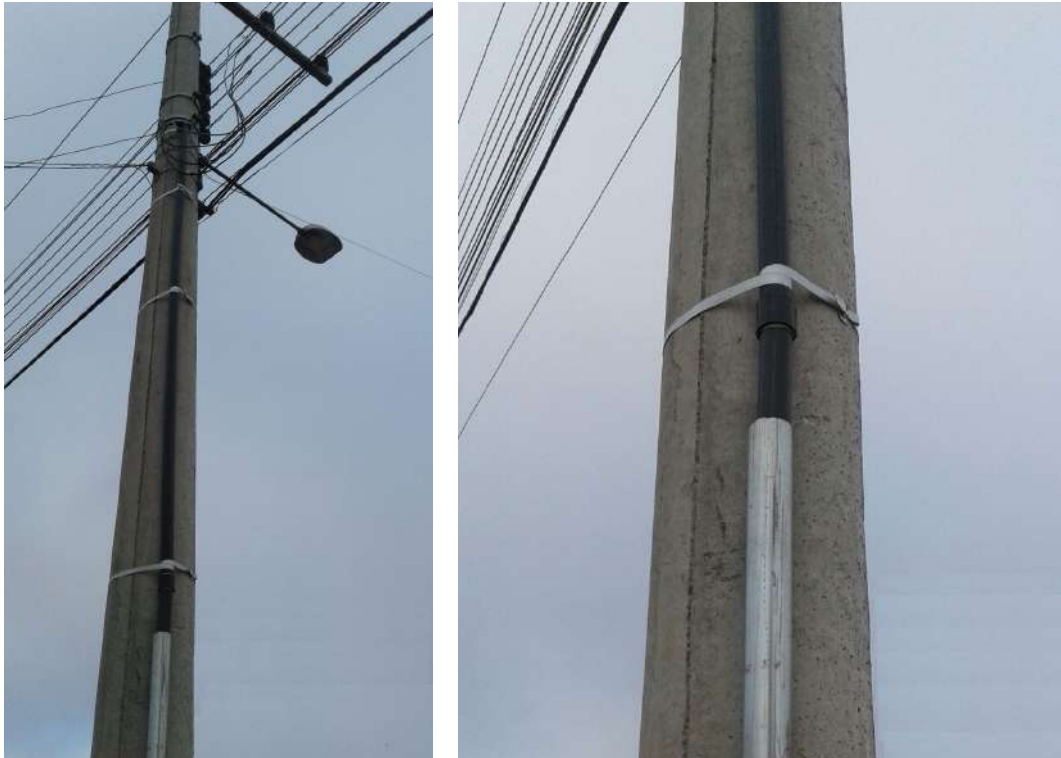
Fotos ilustrativas 01 e 02 dos anexos G e H – Detalhe do eletroduto junto ao poste
